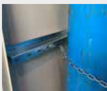
Catene di sicurezza per fissaggio bombole
